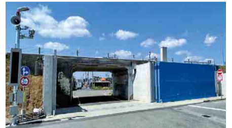
九十九里町不動堂の陸閘
