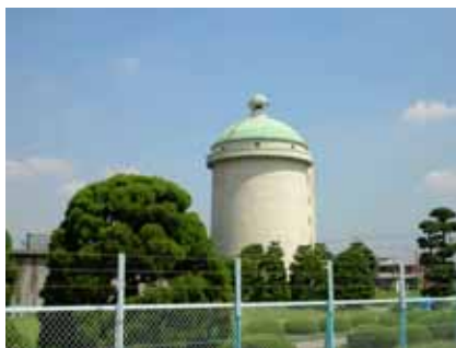
千葉県水道局栗山配水塔（松戸市）
