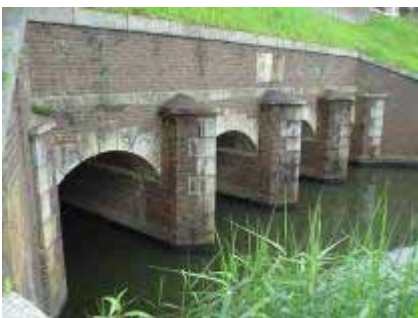
柳原水閘（松戸市）
