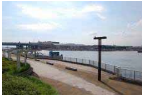
船橋港親水公園（船橋市）
