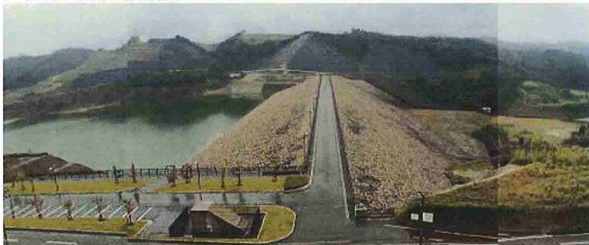
フィルダム工事（完成後）
