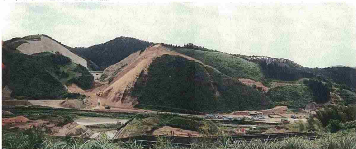
フィルダム工事（着手前）
