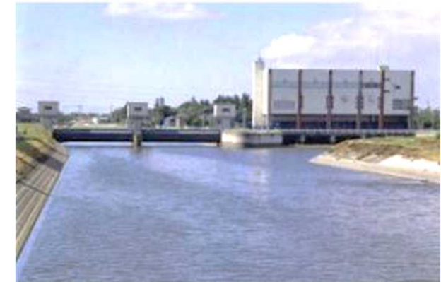
新川用排水機場（東庄町）
