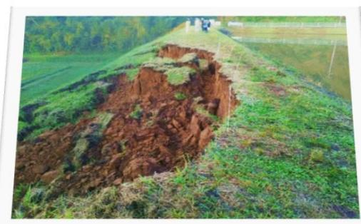
令和元年10月25日の大雨により、堤体の一部が崩落したため池。このような状態になると、必要な時に大切な水が使用できなくなる恐れがあります。
