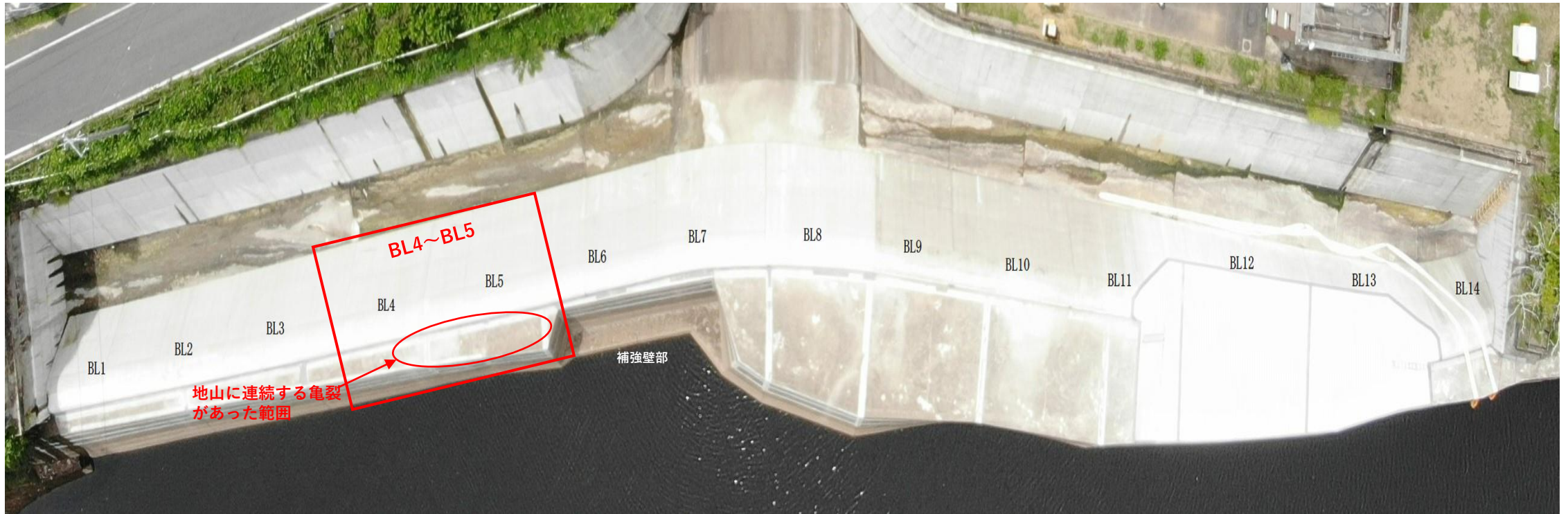
側水路平面（真上から）
