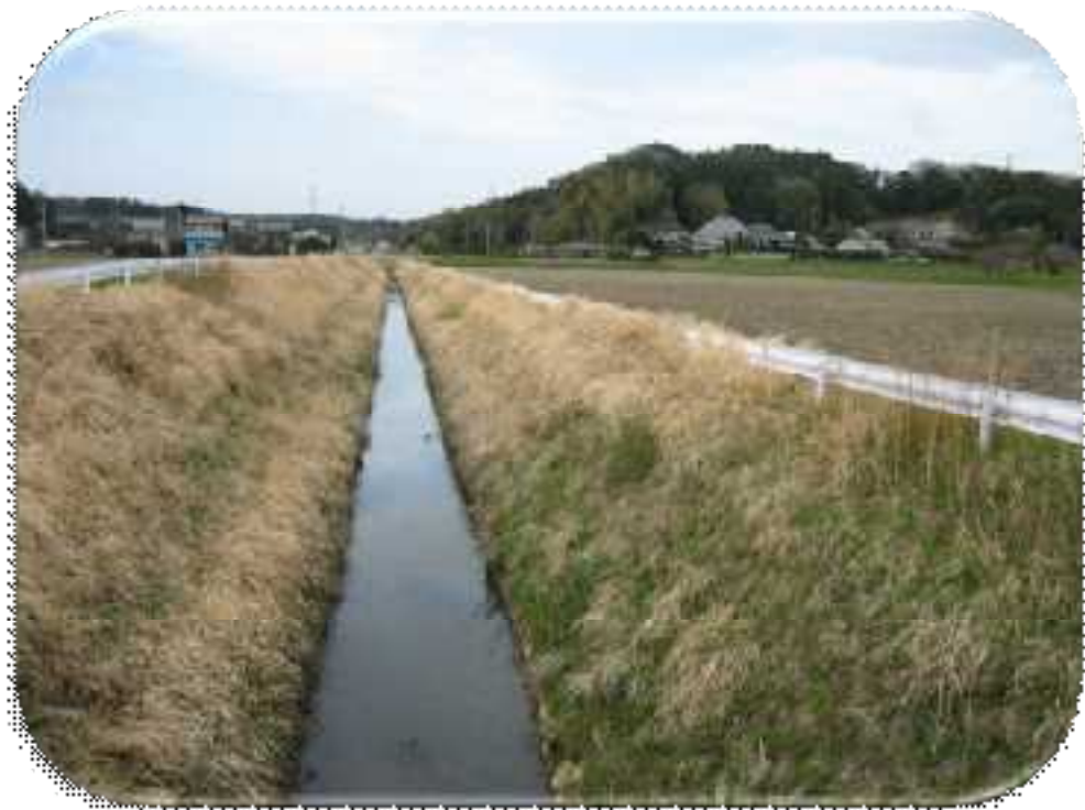
【完成した排水路】
