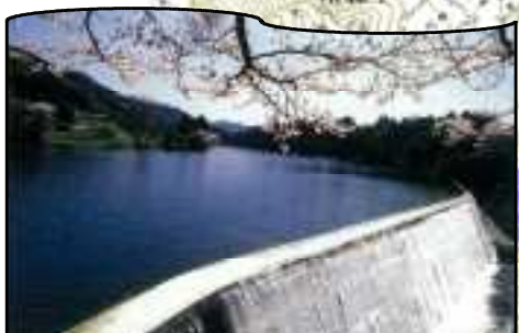
三島ダムの春 [余水吐からの全景]
