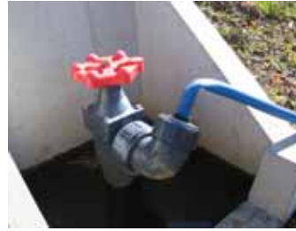
施設栽培や裏作作物への 給水状況 (アタッチメント使用)
