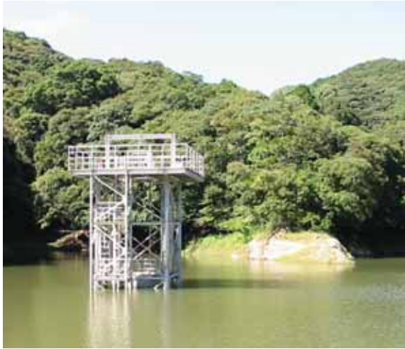
ため池 一の沢堰 取水塔
