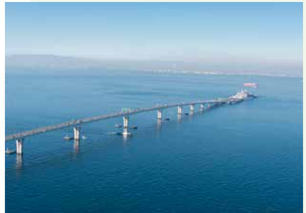
Đường cao tốc Tokyo Bay Aqualine 東京湾アクアライン
