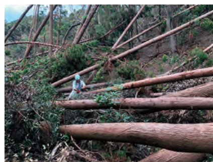
復旧作業の様子
