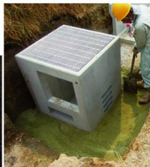
設置作業風景
