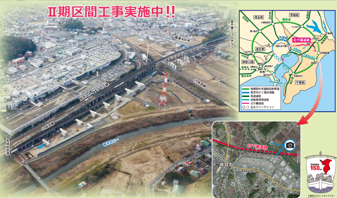
仮称土屋橋と仮称下金山橋の整備状況(令和5年2月撮影)
