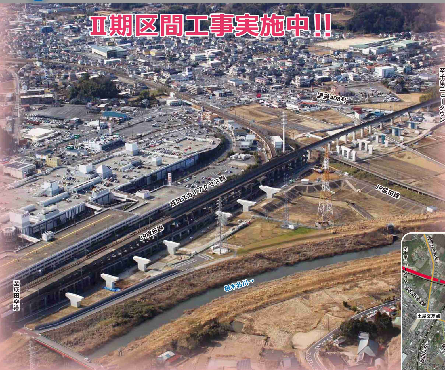
仮称土屋橋と仮称下山橋の整備状況(令和3年2月撮影)
