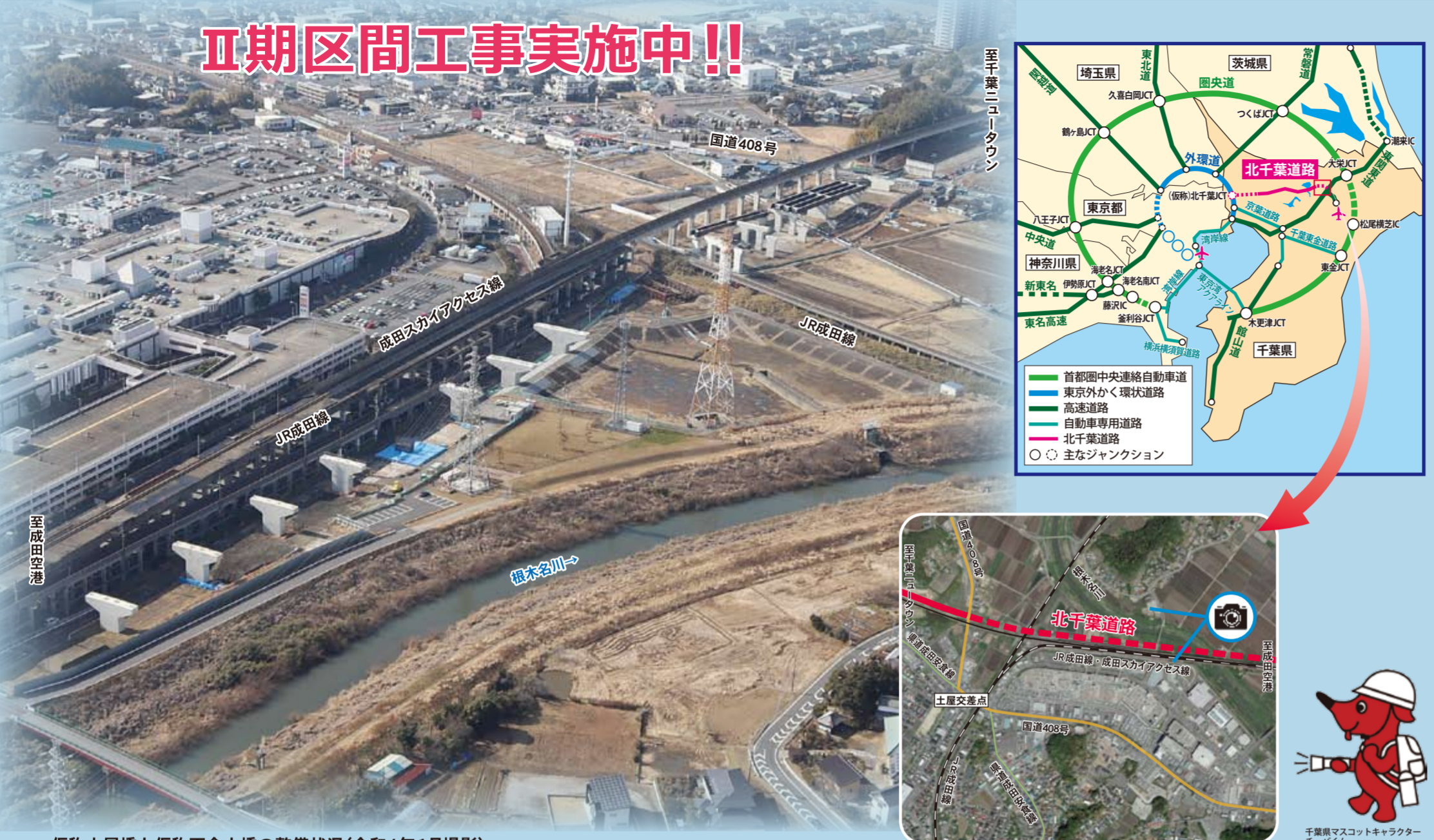
仮称土屋橋と仮称下山橋の整備状況(令和4年1月撮影)
