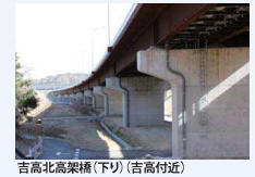
吉高北高梁橋(下り)(吉高付近)
