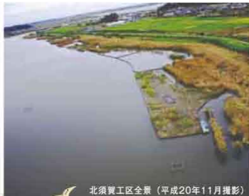
北須賀工区全景 (平成20年11月撮影)
