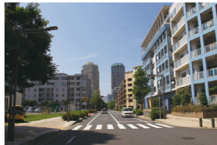
無電柱化されたベイタウンの街並み Makuhari Bay Town townscape with the utility poles removed
