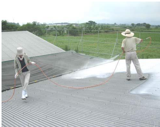
↑屋根への石灰の吹き付け
