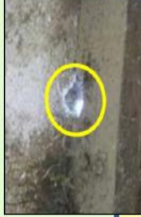
壁等の破損修繕
