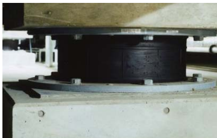
免震装置イメージ(積層ゴム)
