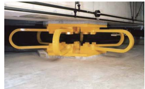
免震装置イメージ(鋼製ダンパー)
