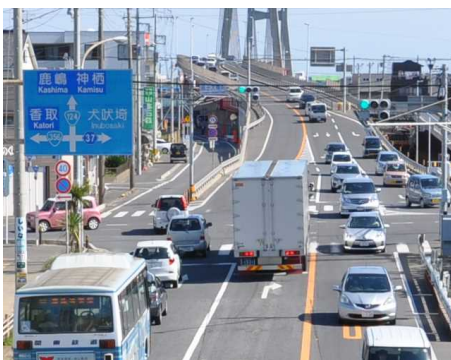
整備後の交差点状況
