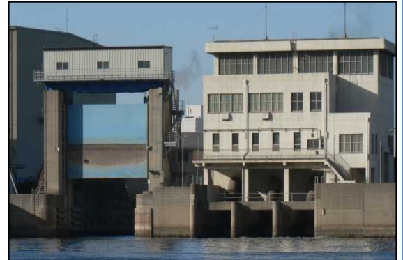
S47年に建設された栄水門、栄排水機場
