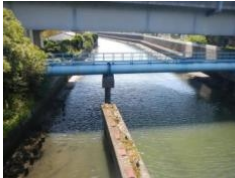
二俣水路 下流を望む
