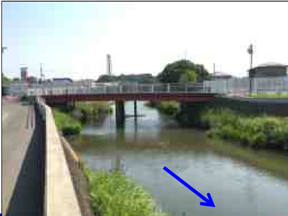
【高崎川】 樋之口橋(現在架替中)
