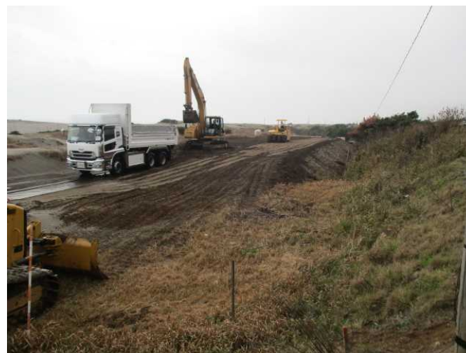
他事業からの建設発生土を利用した築堤整備
