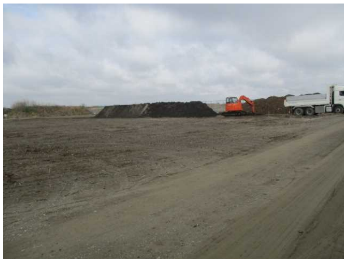
他事業からの建設発生土を利用した築堤整備
