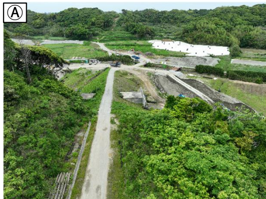
八木拡幅の状況
