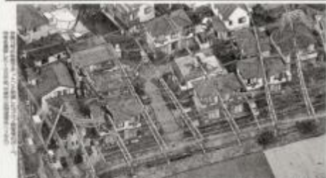
強風で倒壊した鉄塔 (経産省資料より)
