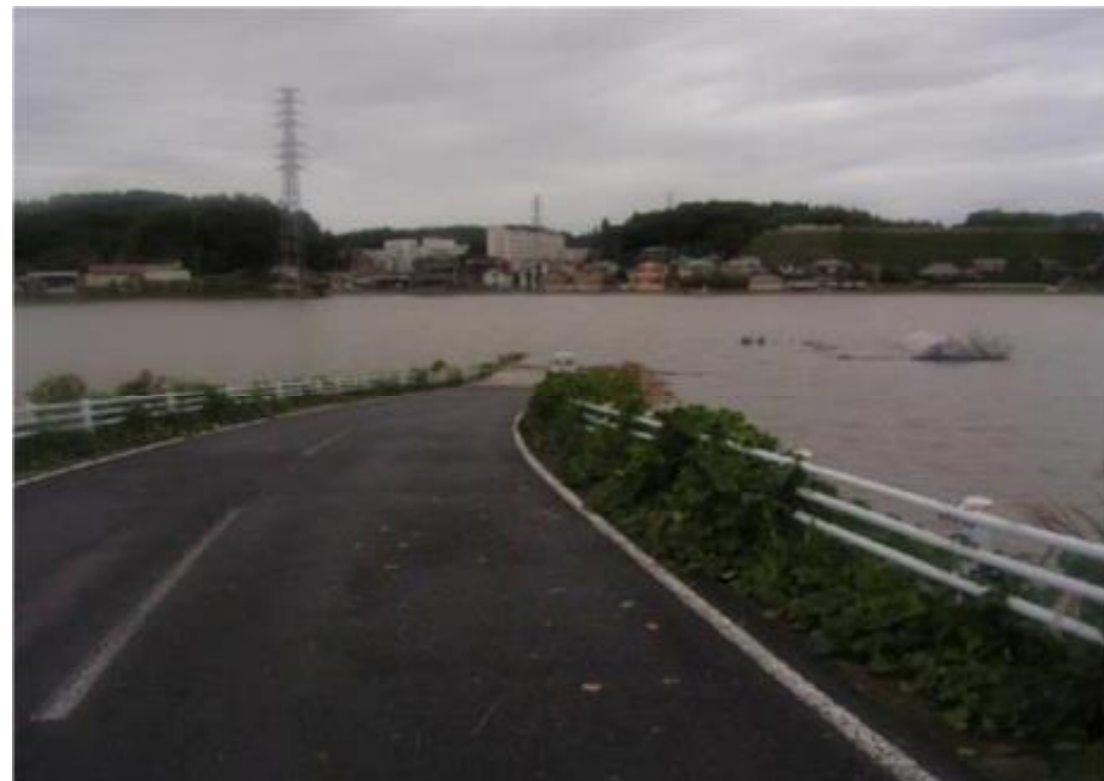
平成25年10月15-16日台風26号 根木名川押畑橋から押畑地区方向を撮影
