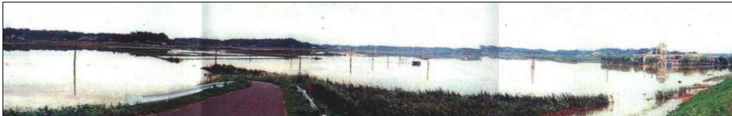
平成8年9月22日洪水 根木名川右岸荒海川合流点上流付近 被害状況(写真背後が荒海川)
