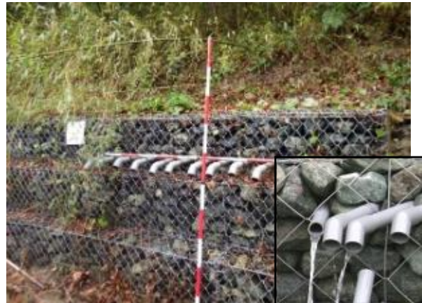
横ボーリング工
