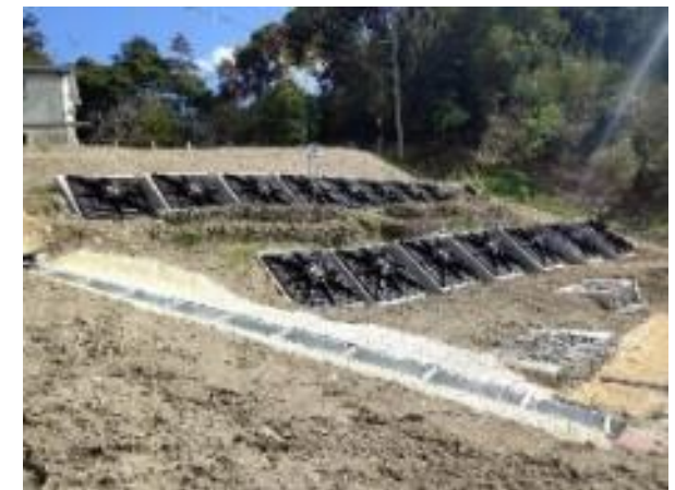
グラウンドアンカー工
