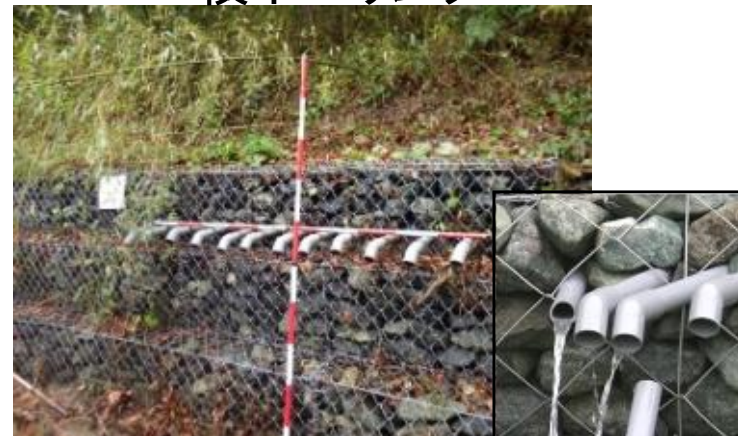
横ボーリング工
