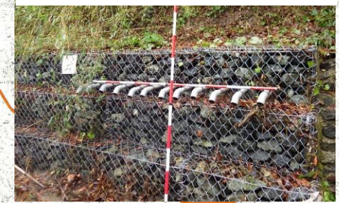
横ボーリング工
