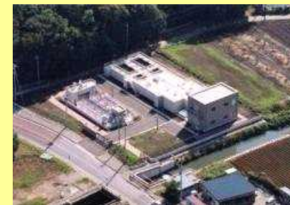
逆井河川浄化(リン除去)施設
