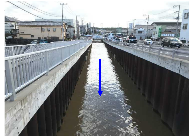
若宮橋上流(完成)
