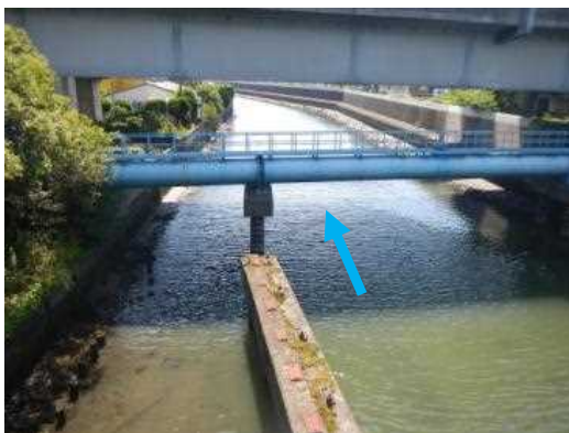
二俣水路 下流を望む
