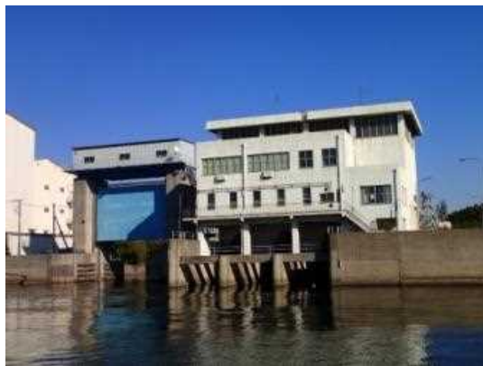
栄排水機場・水門 外観
