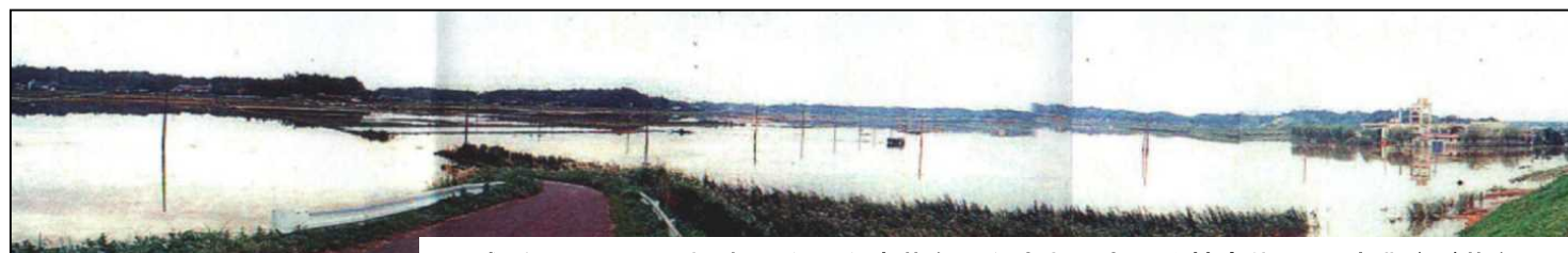
平成8年9月22日洪水 根木名川右岸荒海川合流点上流付近 被害状況(写真背後が荒海川)
