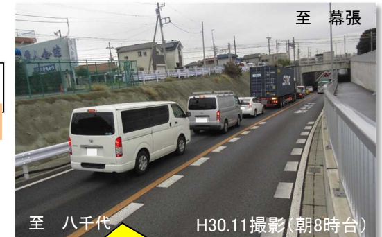
〈暫定2車線供用後の状況〉
