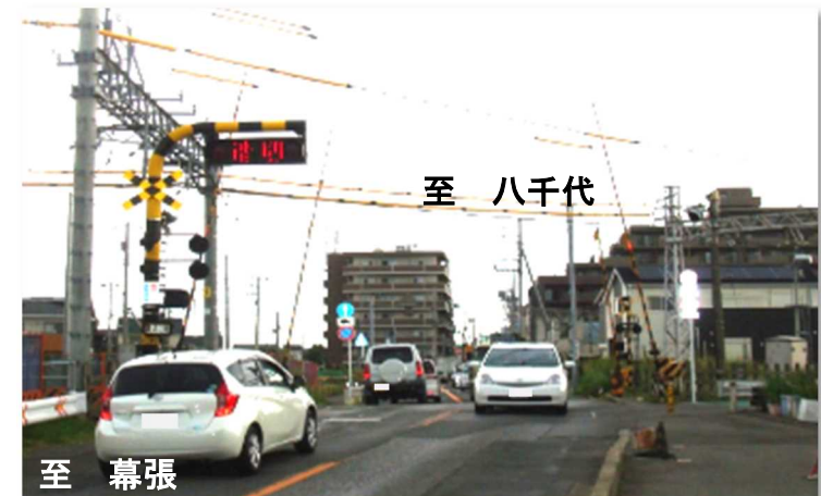
〈京成本線 実叡第4号踏切の状況〉
