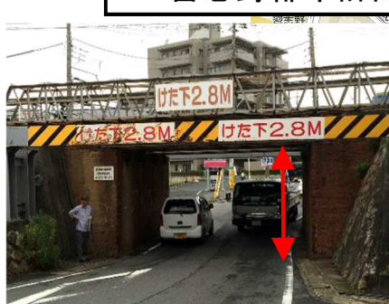
大型緊急車両の通行困難
