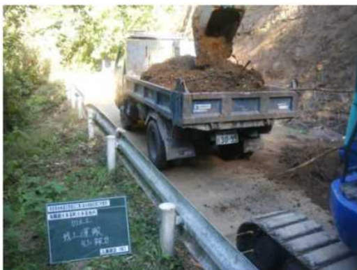
建設発生土の流用
