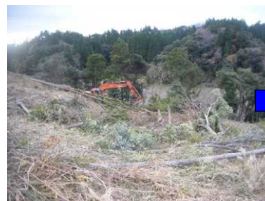
造成工事により木材が発生
