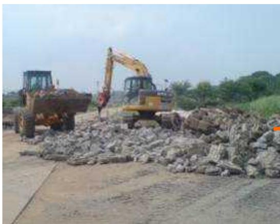
既設護岸等のコンクリート塊を再利用した根固め工
