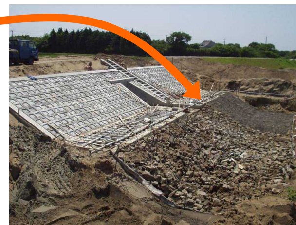
既設護岸等のコンクリート塊を再利用した根固め工
