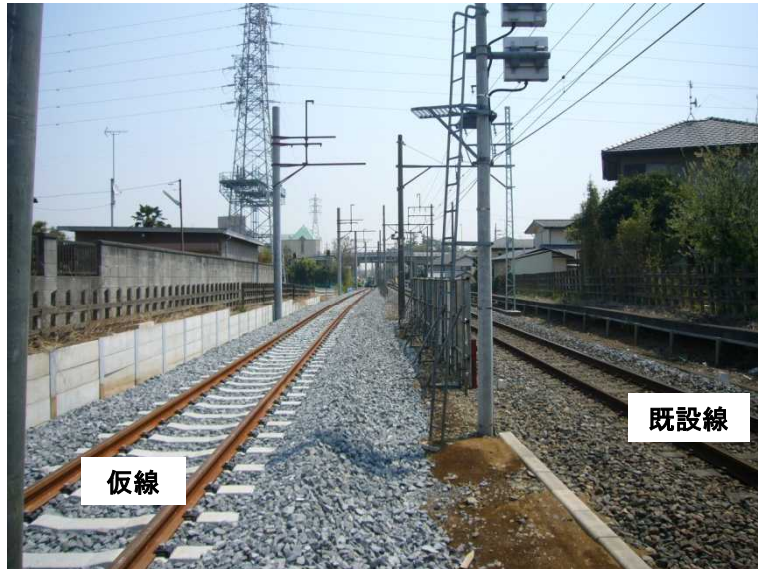
仮線敷設状況
