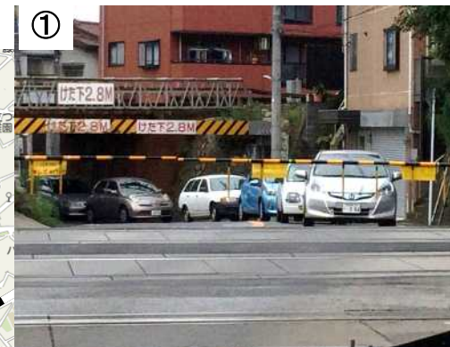
京成本線との踏切が交通の流れを分断し、慢性的な交通渋滞となっている。
