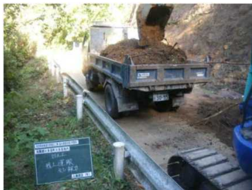
建設発生土の流用
