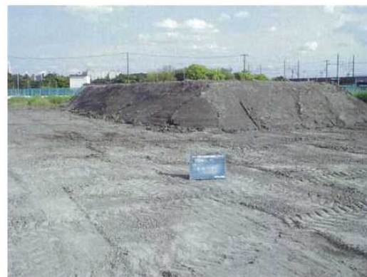
掘削土砂の流用
