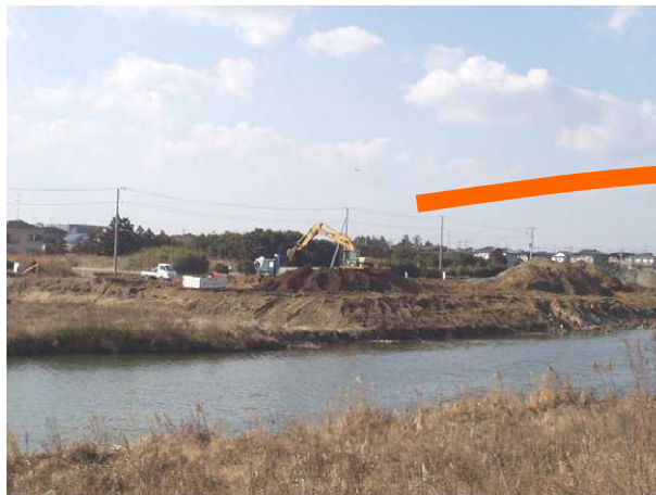
掘削土を再利用した築堤整備状況
