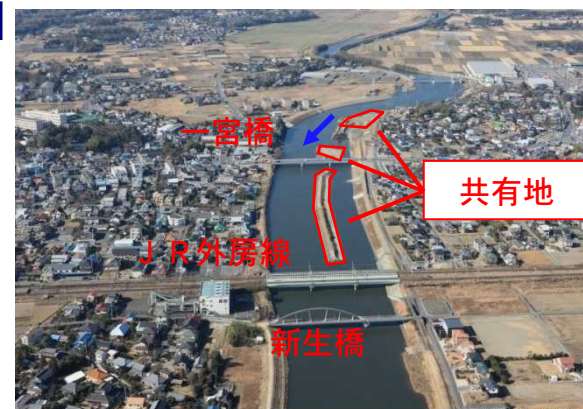
【一宮橋周辺】 (共有地)
