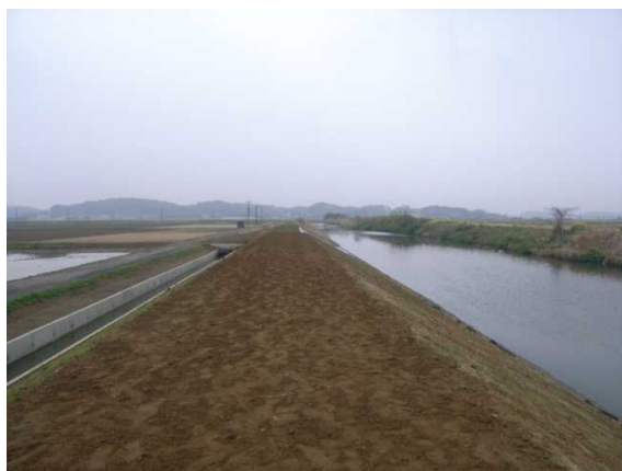
急傾斜地崩壊対策事業等の発生土を盛土材として利用
