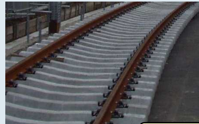
枕木、レール、路盤材の転用
