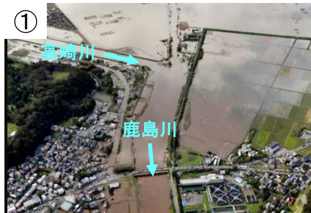
鹿島川の浸水被害状況(1)
