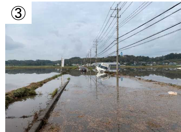
県道の浸水被害状況
