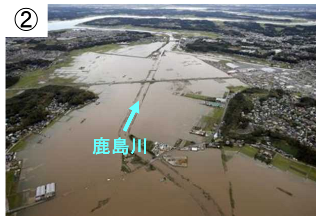
鹿島川の浸水被害状況(2)
