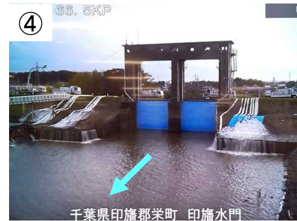
TEC-FORCE排水状況
