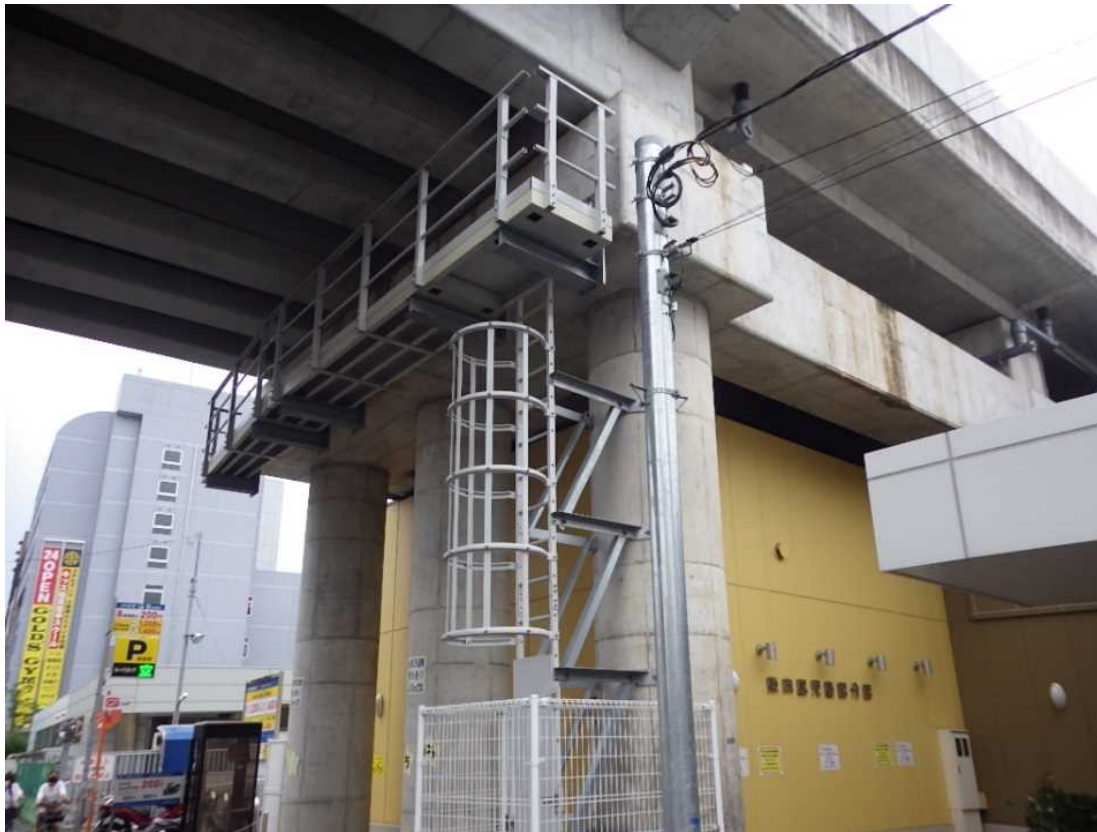
点検台設置イメージ(京成押上線連続立体交差事業: 明治通り交差点)
