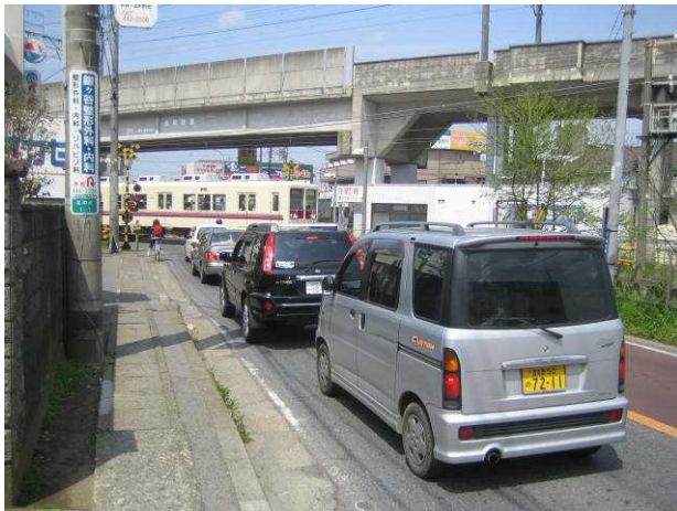
踏切除却前(北初富1号踏切)
