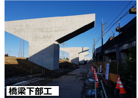
▼写真① (橋梁区間)
