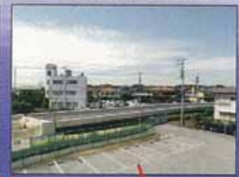
(仮称)大柏川 渡河部橋:完成
