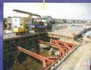
(仮称)B1・B2橋:工事中 平成22年度完成予定
