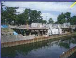
八方橋:工事中 平成22年度完成予定
